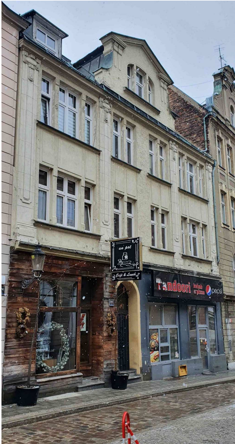
Fot. 1. Elewacja frontowa kamienicy przy ulicy Sierociej 5/6.
