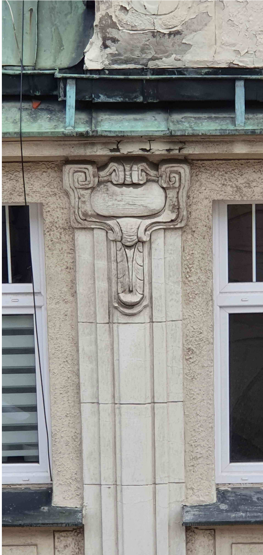
Fot.6. Elewacja frontowa kamienicy przy ulicy Sierociej 5/6. Fragment detalu sztukatorskiego.
