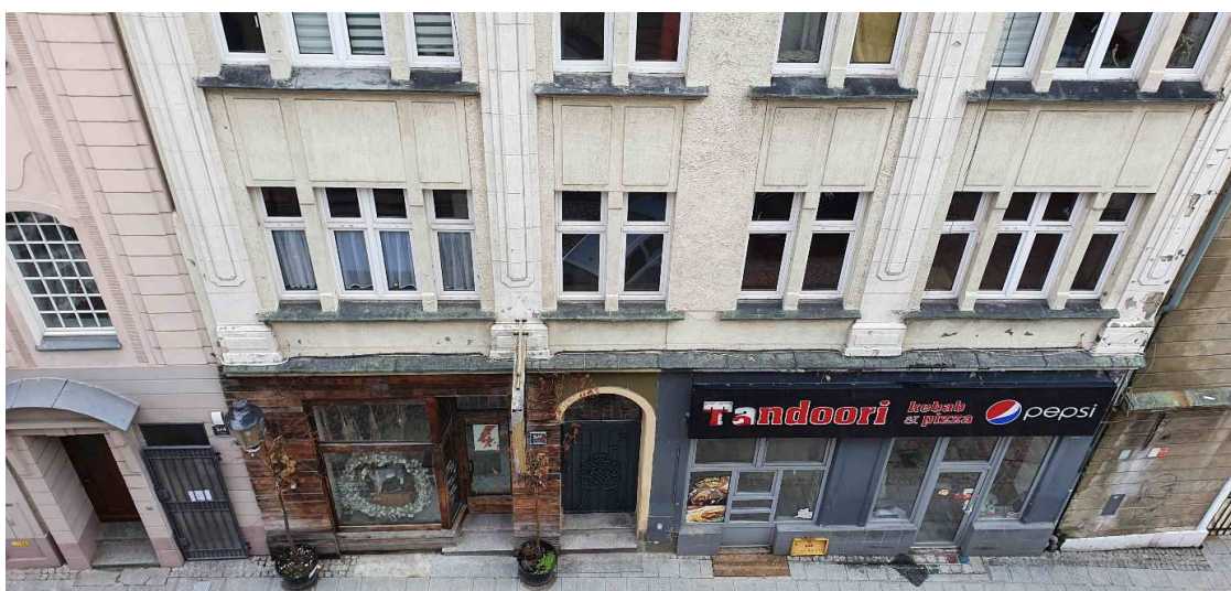
Fot. 2,3,4. Elewacja frontowa kamienicy przy ulicy Sierociej 5/6.
