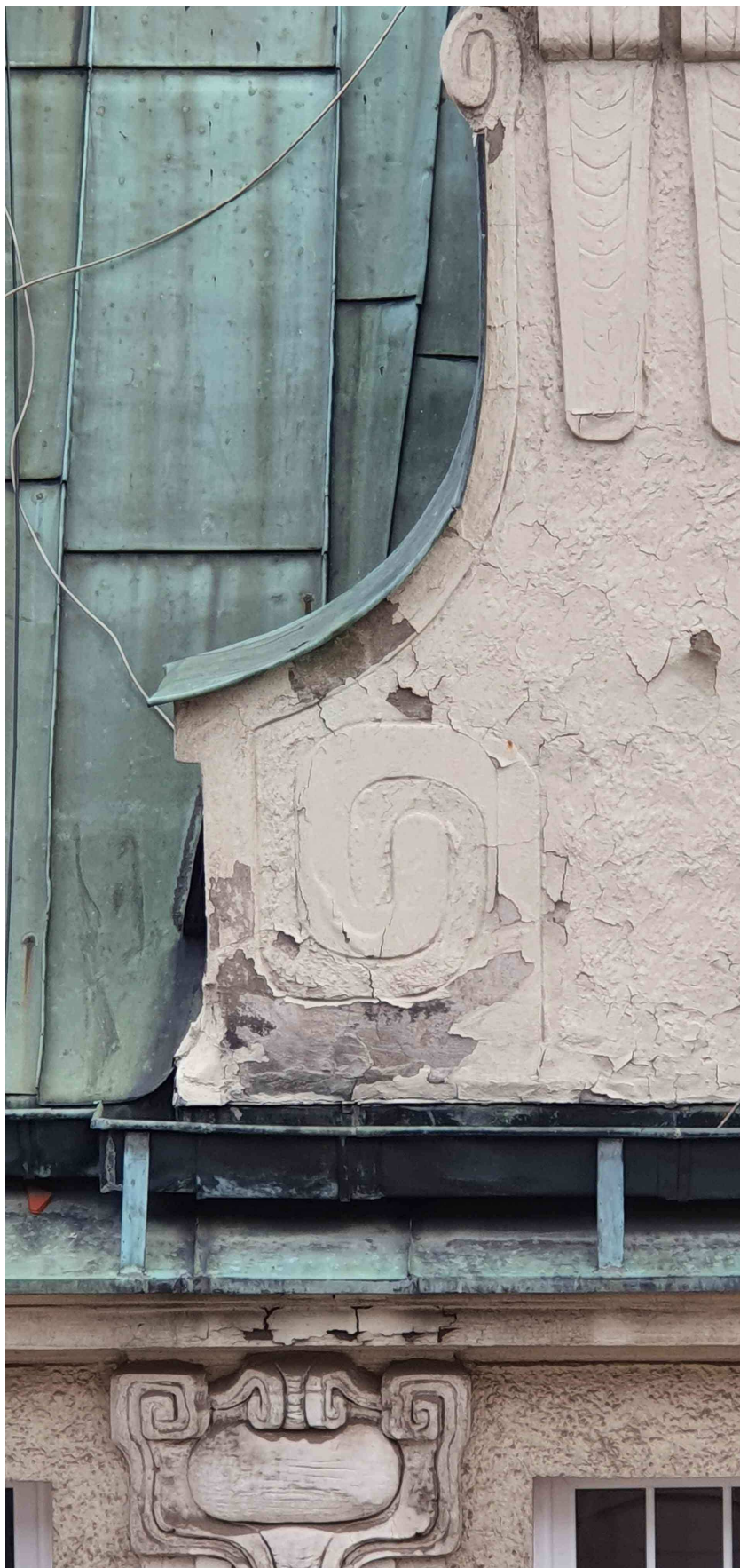
Fot.7. Elewacja frontowa kamienicy przy ulicy Sierociej 5/6. Fragment detalu sztukatorskiego.
